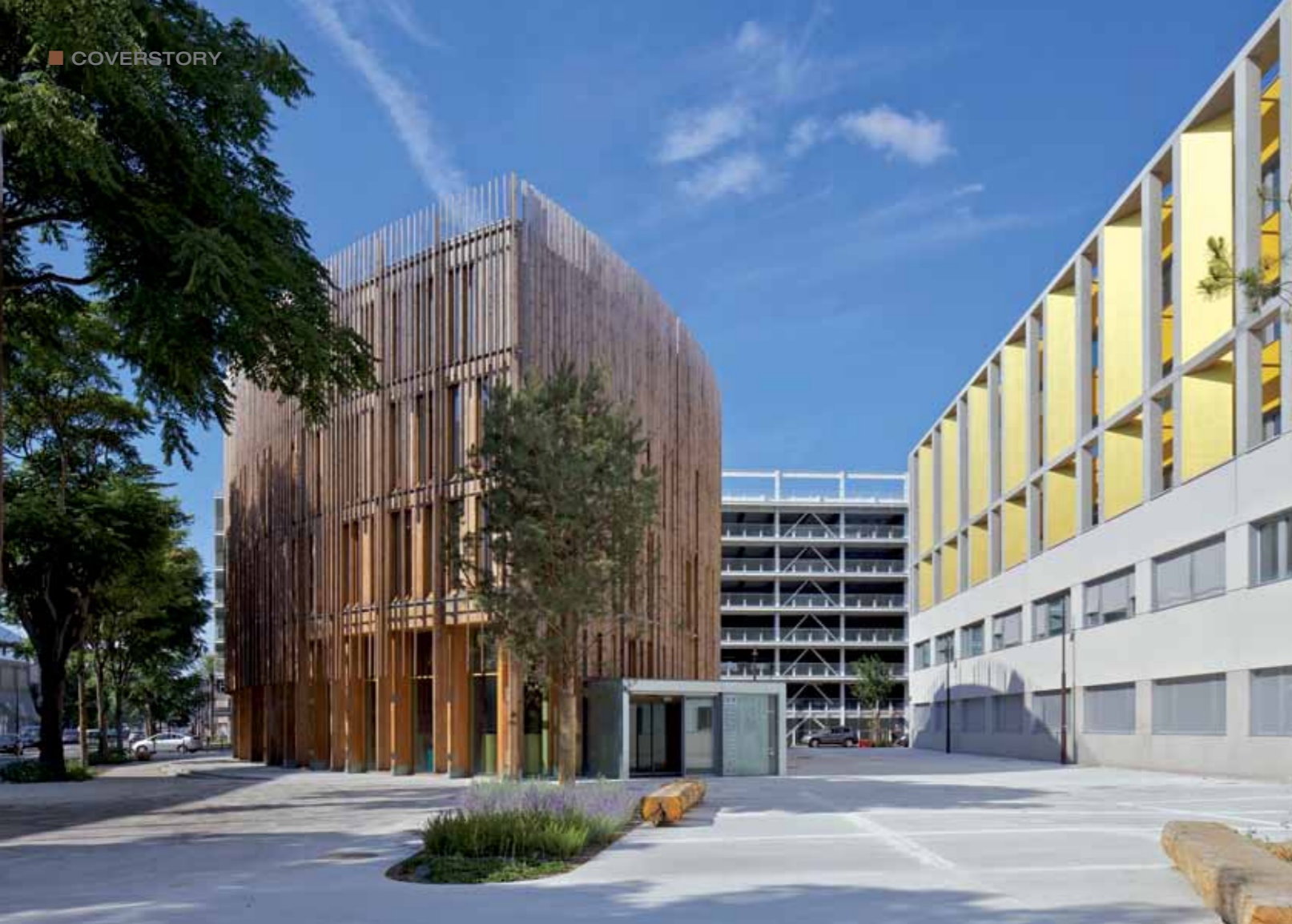
Die neue Zentrale von Atlanbois in Nantes
